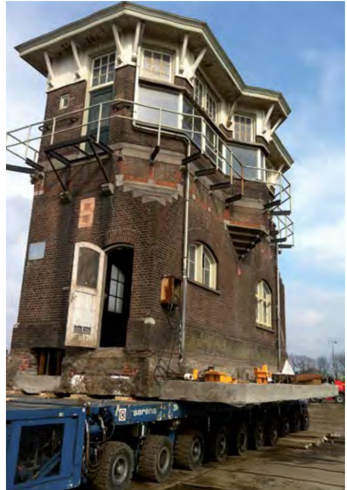
Voormalig seihuis uit 1907 in Roosendaal. In 2013 werd het seihuis verplaatst naar de huidige locatie, de Locloods in Roosendaal. Foto: Moons Architecten
